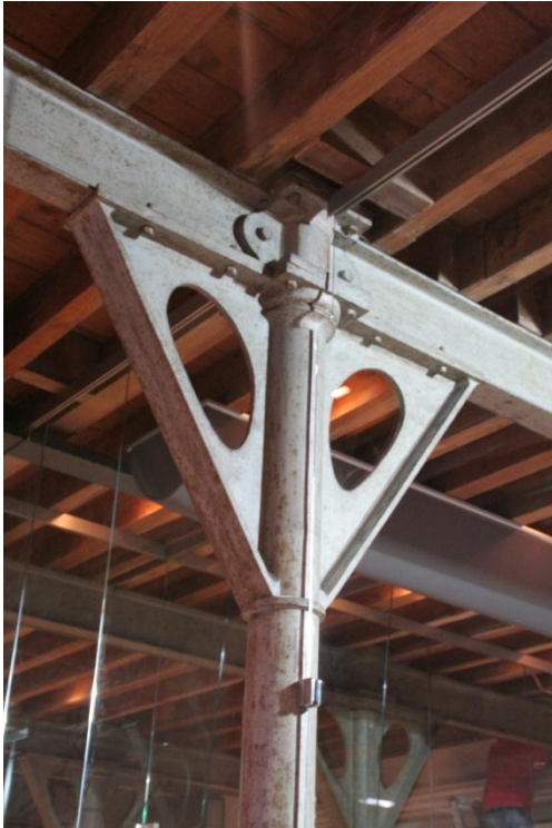
Kolom met aangegoten schoor. Foto: Hooyschuur Architecten
