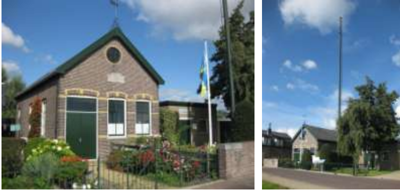
Poldergemaal Het Leven aan de Lagedijk 145 met het oude gemaal uit 1904, de mast uit 1945 en het nieuwe gemaal uit 1966.
