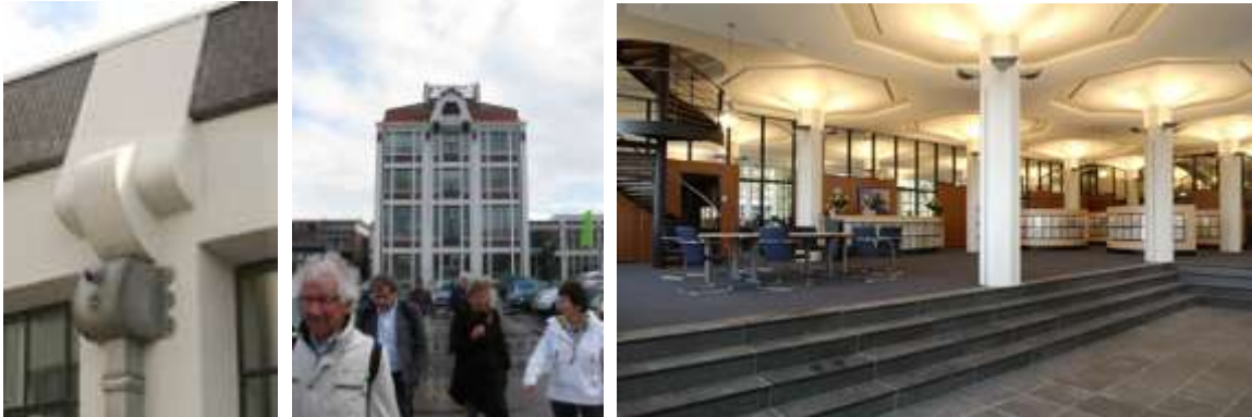
De Petteflat met links een geveldetail. Op de interieurfoto rechts zijn de paddestoelvloeren goed herkenbaar. (linker en rechterfoto komen van de website zaans- industrieel-erfgoed / personen / Jan Goedhart)
