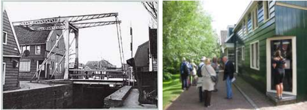
Het huis aan het Langepad 27 in de Domineestuin ( rechterfoto) stond oorspronkelijk in Zaandam aan de Oostzijde naast de Noordervaldeursluis (linkerfoto). De invaart van deze sluis liep taps toe; daarom is de hoek ter plaatse van de entree afgeschuind (de linkerfoto is van Wim Krijt, Zaandam en komt uit het Gemeentearchief Zaanstad. Afbeelding: Noordervaldeurstraat 23, december 1960)
