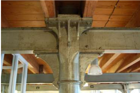
Links de staalconstructie van pakhuis Saigon uit 1898 en rechts pakhuis Java uit 1907 dat een voorbeeld is van de vroegste betonskeletbouw in Nederland. (foto's van Cees Kingma op www. zaans-industrieel-erfgoed.nl )
