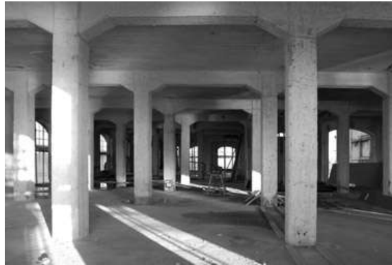
Links de staalconstructie van pakhuis Saigon uit 1898 en rechts pakhuis Java uit 1907 dat een voorbeeld is van de vroegste betonskeletbouw in Nederland. (foto's van Cees Kingma op www. zaans-industrieel-erfgoed.nl )
