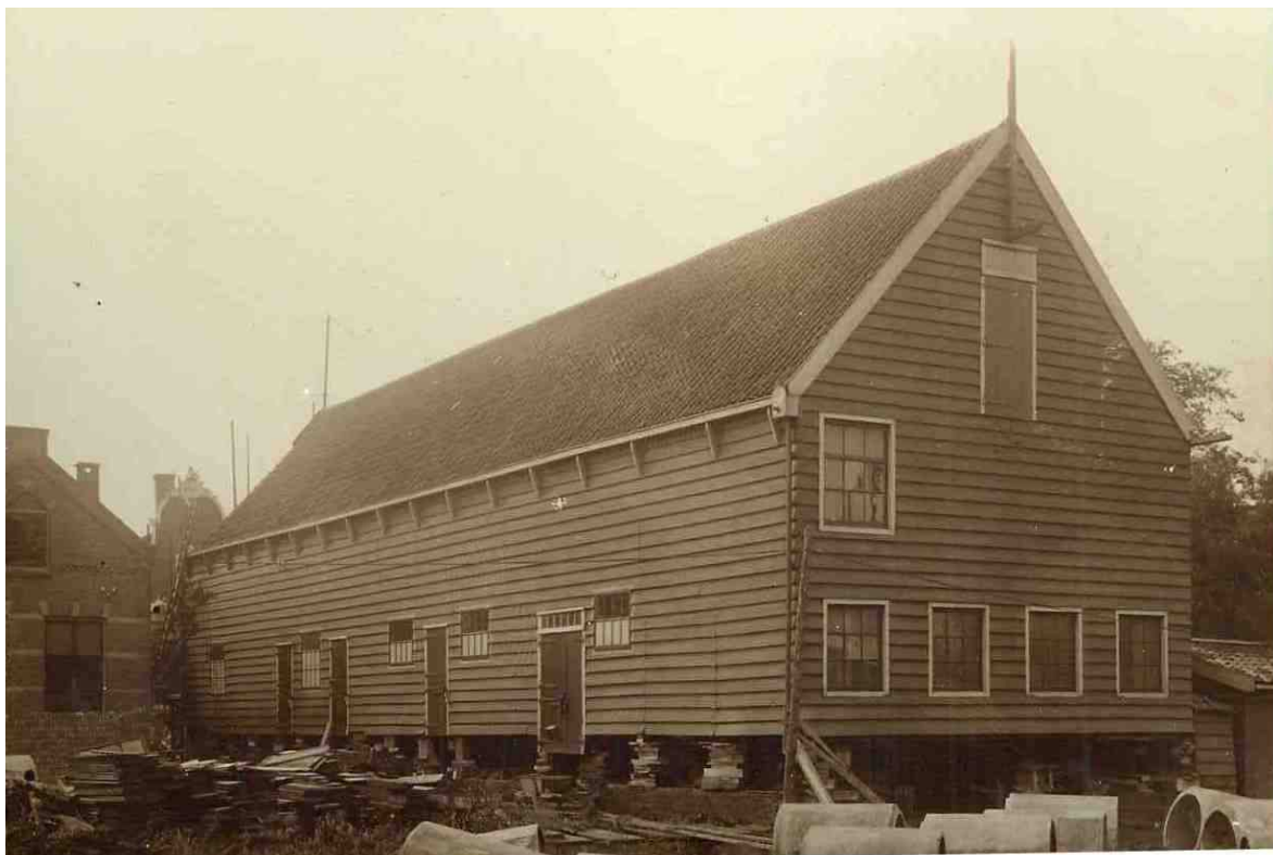
Afb. 11 Het Weversend tijdens het opvijzelen van het pakhuis in 1926. (foto collectie KS)
