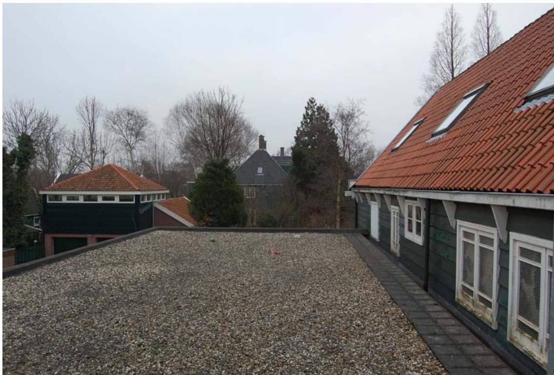
Afb. 33 Het dak van de aanbouw tegen de noordzijde van het Weversend.
