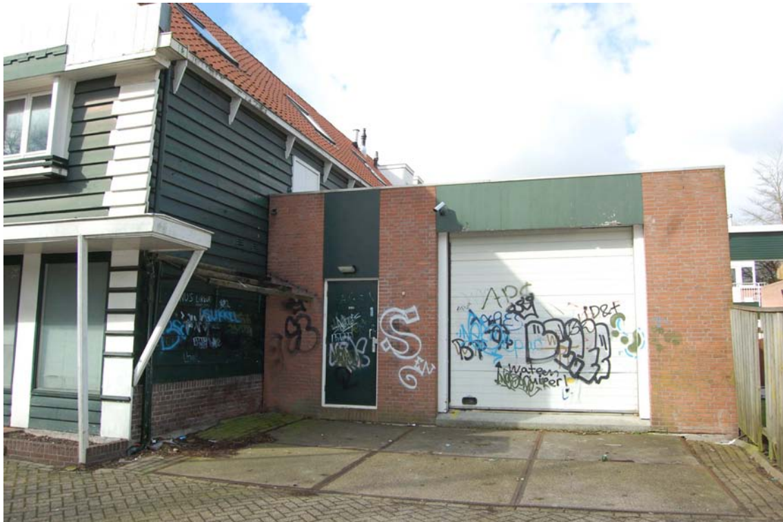
Afb. 32 De aanbouw uit 1985 is op een botte wijze tegen de noordgevel gebouwd. De gesloten gevel nodigt uit tot het aanbrengen van graffiti.
