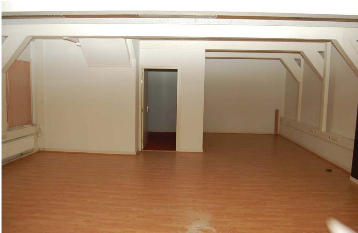
Afb. 34 De begane grond met de kenmerkende houten balk constructie
