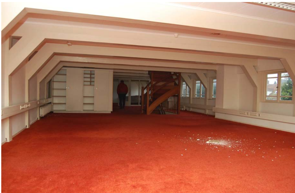
Afb. 35 De verdieping met de houten balk constructie en nieuwe trap.
