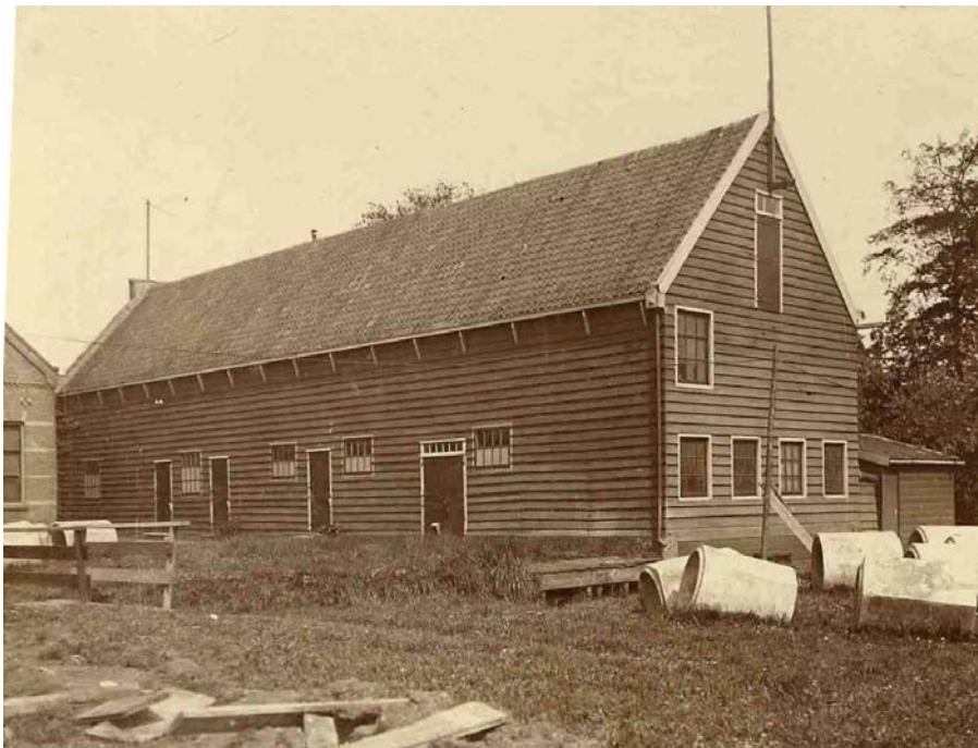
Afb. 5. Het pakhuis vlak voor de verbouwing in 1926. Op de voorgrond zijn rioleringsbuizen zichtbaar, die vermoedelijk zijn gebruikt voor de putring fundering onder het huis. (foto collectie KS)
