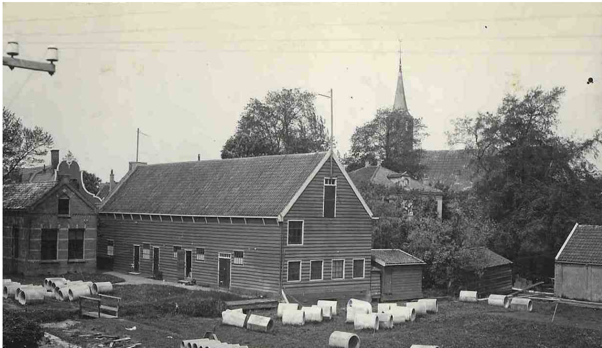
Afb. 10 Het Weversend in 1926, vlak voor de verbouwing. De betonnen ringen waren vermoedelijk bestemd voor de stabilisering en fundering van het huis. Een andere mogelijkheid is de aanleg van een nieuwe riolering onder het Padlaan, die toen tegelijkertijd werd verbreed. (foto collectie KS)
