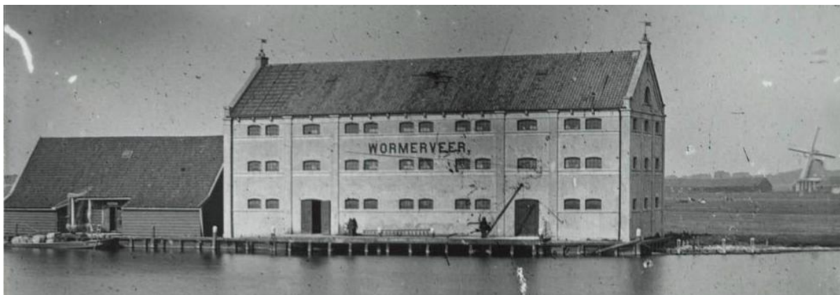
Rechts pakhuis 'Wormerveer', links het pakhuis 'Aanleg'. Foto: GAZ 21.07543 Collectie ZOV
