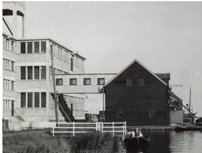
Pakhuis 'Mooriaan' met de luchtbrug naar de nieuwe, binnendijks gelegen, fabriek.
