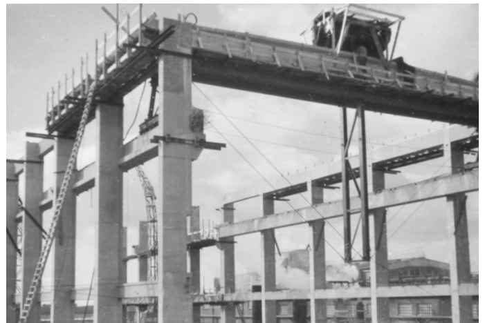
De door Klinkenberg geconstrueerde verticale hulpbalk, die met enkele staaldraden, de montagebalk voor doorbuigen kon behoeden.
