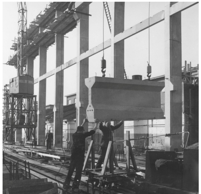
Een geprefabriceerd blok beton wordt naar de constructiebalk voor de dakspant gehesen.
