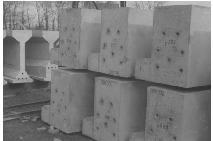
De geprefabriceerde blokken beton werden aangevoerd vanaf de betonfabriek. Let op de ronde uitsparingen in de blokken waar later de staalkabels doorheen zullen worden getrokken om de blokken aan elkaar te rijgen.
