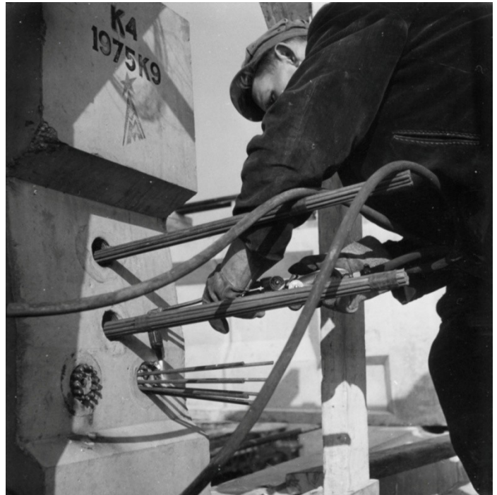
Nadat de stalen kabels aan één kant zijn vastgezet met een conische klos worden de kabels met een snijbrander afgekort.
