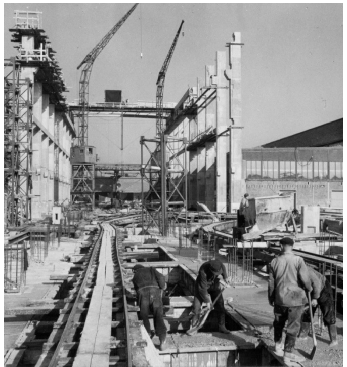
Een overzicht van de bouwplaats met de tijdelijke infrastructuur zoals de spoorrails en de kranen.
