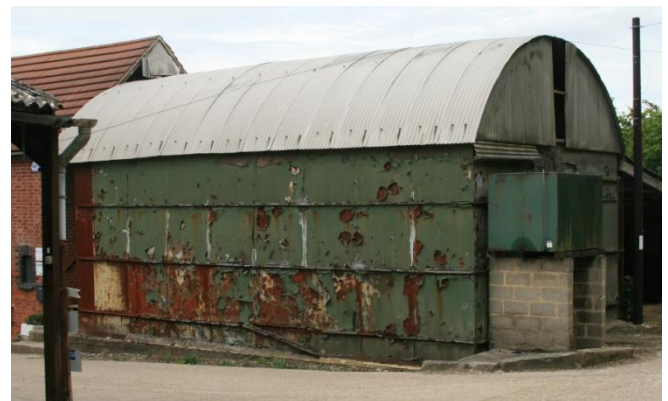
Op veel Engelse boerderijen zijn nog Nissen hutten of oude hangars van golfplaat te vinden. Brocklands farm West Meon, juli 2010.
