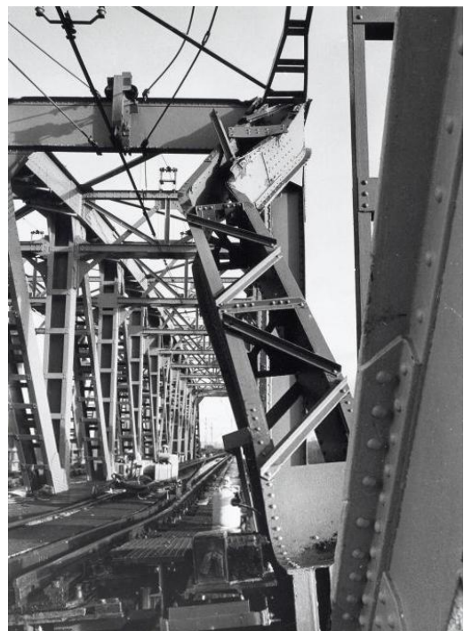
De Hembrug na aanvaring door het Amerikaanse kraanschip, Choctaw II.
