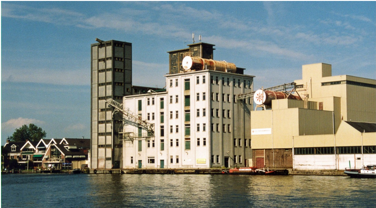
De voormalige gortpellerij Zwaardemaker in Zaandam is nu een appartementengebouw. (foto Jur Kingma)
