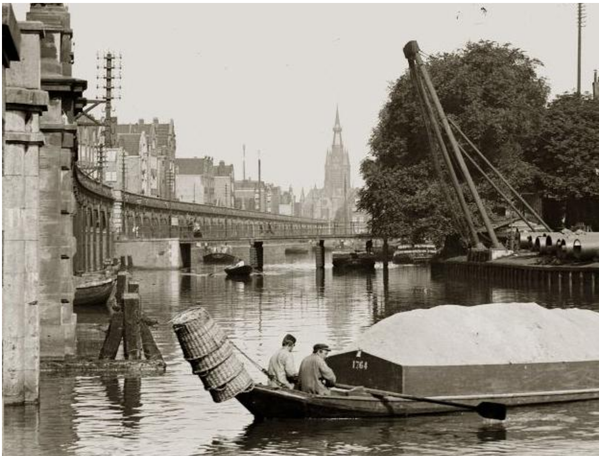
Westerdok in Amsterdam bij het viaduct. Gezien naar achterzijde huizen Haarlemmer Houttuinen/Eilandsgracht. Rechts: Bickersplein Bron: Stadsarchief Gemeente Amsterdam
