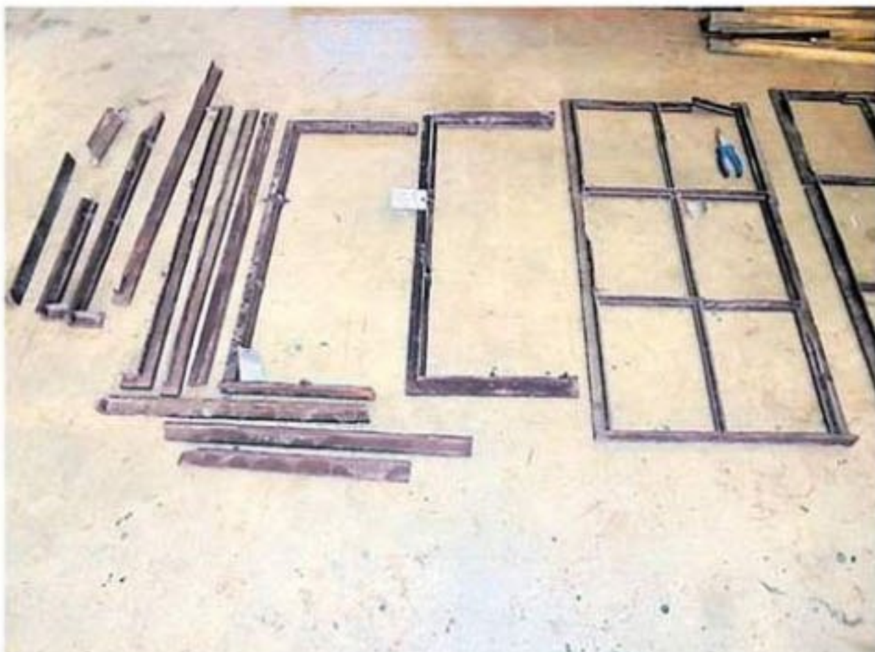
Restauratie gebouw de Vrede Zaandam: sommige gietijzeren ramen zijn letterlijk van ellende uit elkaar gevallen. FOTO DE GROOT & DE BOER
