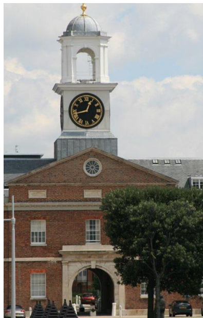
Een van de voormalige hoofdgebouwen van de voormalige dockyard. (foto Jur Kingma, augustus 2010)
