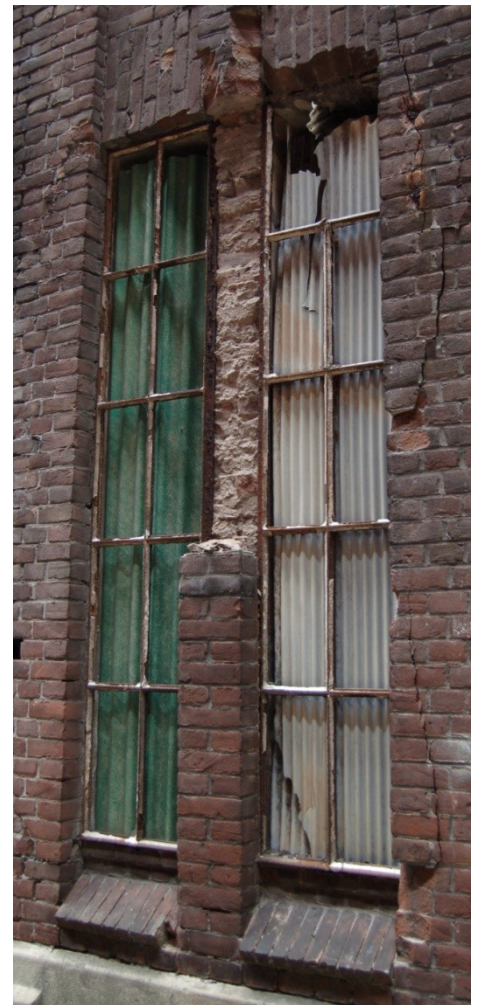
De meesten ruiten zijn gesneuveld, al het glas is verwijderd en de vensters zijn ‘gedicht’ met groene golfplaten. Foto: Cees Kingma
