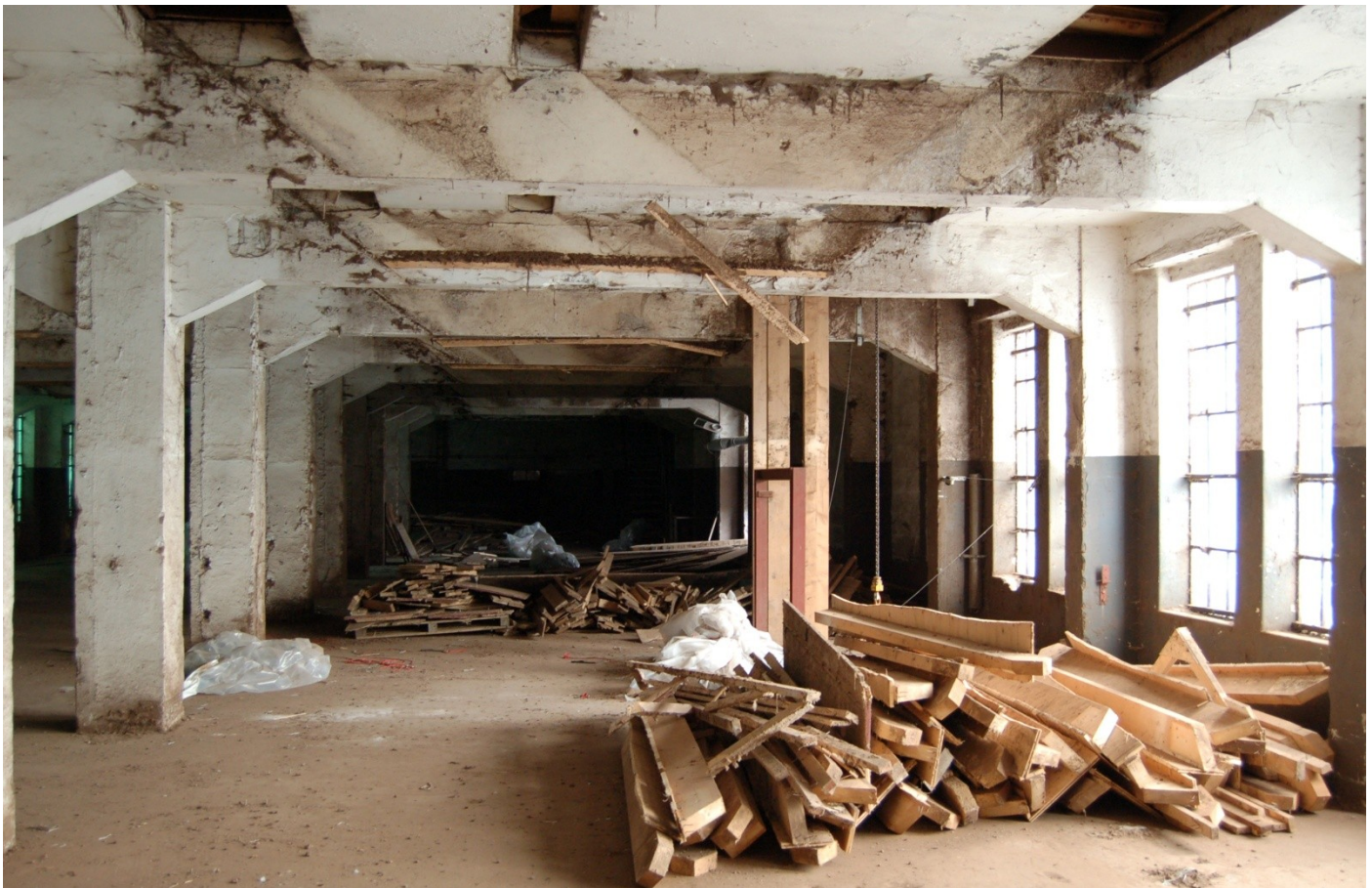
De houten karens zijn verwijderd, er resten nog slechts grote sleuven in de betonnen vloeren. Foto: Cees Kingma
