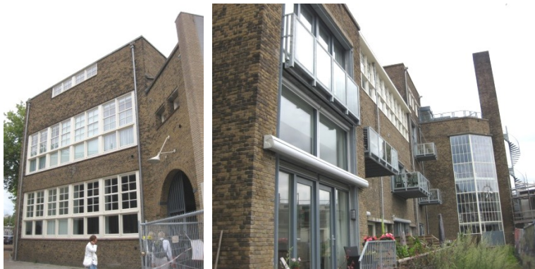
Huidige situatie met glazen balkons die als duidelijk herkenbare elementen zijn toegevoegd. De poort (zie foto links) blijft gehandhaafd. Let op de karakteristieke doorgaande glaspui van het trappenhuis op de foto rechts.
