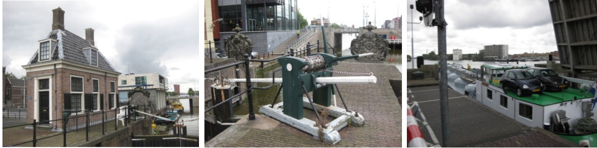
Bij de sluis horen een sluismeester- en een accijnshuisje (Dam 1 en 1b) uit 1724. (bron 30)
