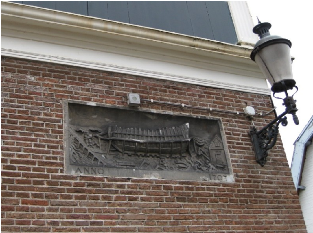
In de noordgevel is een steen gemetseld met daarop een scheepswerf.
