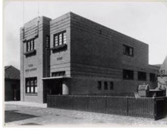
(foto rechts en foto's onder: bron 35)
