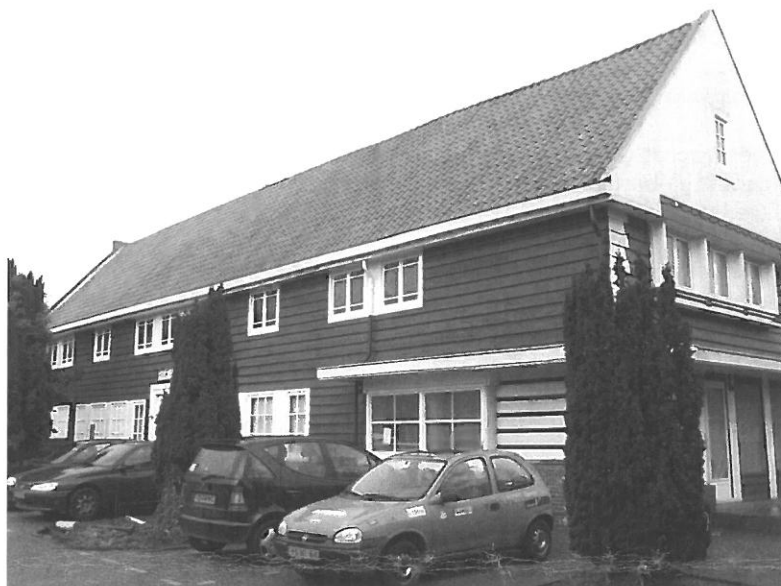
Voorgevel en rechter zijgevel
