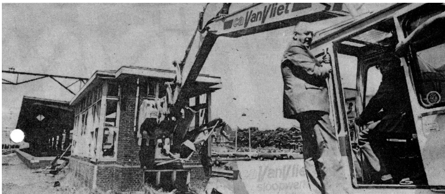
Floor de Rooy mocht als eerste „zijn eigen" seinhuisje een dreun met de slopershamer verkopen. Zijn zoon Eddy, de laatste seinhuiswachter, staat eveneens bij zijn vader op de bok van de graafmachine. (Foto Prentekst)
