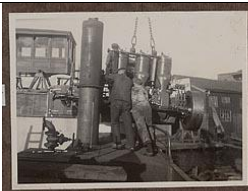
Motor wordt aan boord gehesen van motortankschip "Olievos II op 2 september 1934, gebouwd voor NV. Oliefactorij Pieter Bon te Zaandam. Afmeting 40.30 x 6.25 x 2.20 meter. GAZ Fotonummer: 25_103_06285
