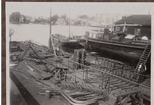
1900 meter stoomleiding ligt klaar om in het schip "Olievos II" te worden gebracht. Motortankschip "Olievos II" in aanbouw 1934, voor NV. Oliefactorij Pieter Bon te Zaandam. Afmeting 40.30 x 6.25 x 2.20 meter.
