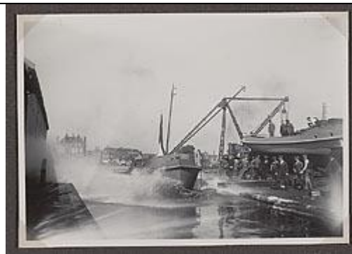
Tewaterlating van een van de motorbarkassen. GAZ Fotonummer: 25_102_06139
