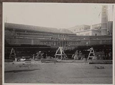
3 meter verlenging motorschip Johanna, eigenaar N. Baarsen te Amsterdam in april 1934. GAZ Fotonummer: 25_103_06276
