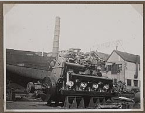
Motorcoaster Tiny in aanbouw. De dieselmotor staat klaar om geplaatst te worden. Opdrachtgever J. de Vries, Groningen. GAZ Fotonummer: 25_104_06296
