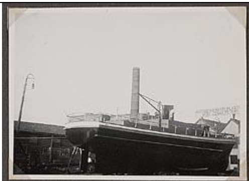
Inspectieschip Valk in aanbouw in 1938. GAZ Fotonummer: 25_102_06219
