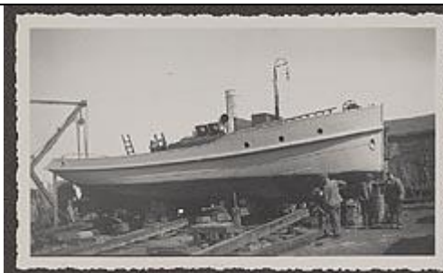
Motorsleepboot "Roger", gebouwd voor Franse rekening, voorzien van 150 PK Kromhout Dieselmotor, type 3-H-4 met bergings- en brandbus centrifugaalpomp, capaciteit 100 ton per uur. afm. 16x4.10x1.90 meter in mei 1936, Marokko, 150 pk motorsleper. gebouwd. GAZ Fotonummer: 25_102_06162
