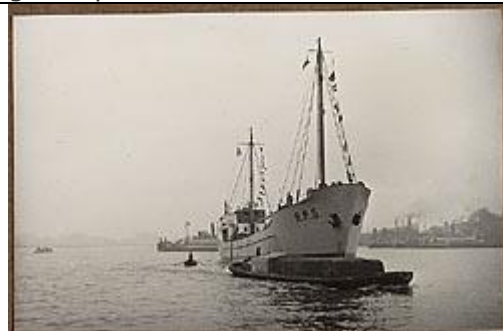
motorcoaster R.P.S. (Rudolf Pieter Schoonheim) gebouwd voor de Rotterdamse Kolen Centrale RKC. Motorcoaster R.P.S. mat 499 brutoregisterton en 940 ton d.w. Bouwnummer 454. Het schip heeft een bijzondere constructie namelijk een dubbele bodem. Op dat ontwerp kreeg de Zaanlandse Scheepsbouw Maatschappij (Z.S.M.) patent. Het schip is geheel elektrisch gelast. Technische proefvaart donderdag 25 januari 1951 en proefvaart met overdracht op zaterdag 27 januari 1951. GAZ Fotonummer: 25_108_06638
