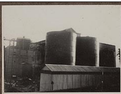
Bouw twee olietanks van 360 m3 voor N.V. Oliefabrieken Het Hart & De Zwaan voorheen Adr. Honig te Zaandam in 1933. GAZ Fotonummer: 25_103_06258
