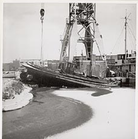
Met de kraan het achterschip lichten om een draad uit de schroef te halen. GAZ Fotonummer: 25_132_07836
