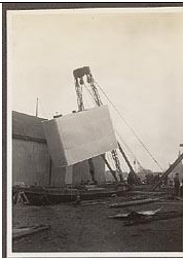
Stookolietank gebouwd voor N.V. Stijfselfabriek de Bijenkorf te Koog aan de Zaan in februari 1935 op de scheepswerf Czaar Peter. Deze tank is geheel electrisch gelast. GAZ Fotonummer: 25_102_06118
