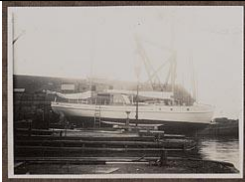
Motorjacht Isolde, eigenaar Gebroeders Vis te Zaandijk in 1934 in reparatie. GAZ fotonummer: 25_103_06277
