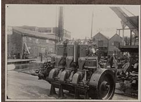
Motor voor motortankschip "Olievos" in aanbouw. Inbouw op de "Czaar Peterwerf" bij de ZSM, Zaanlandse Scheepsbouw Maatschappij, aan het Kalf. Opdrachtgever NV Oliefactorij Pieter Bon Cz. maart 1933
