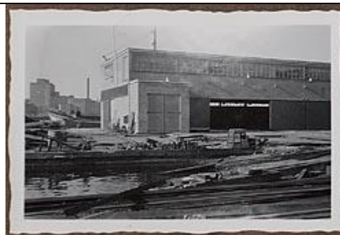
Nieuwe scheepsloods. De oude scheepsloods is reeds gesloopt. GAZ Fotonummer: 25_110_06833
