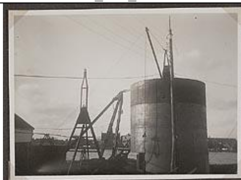
Vijf tanks voor N.V. Noordhollandse Margarinefabriek Zaandijk in maart 1936 gebouwd op het terrein van de scheepswerf Czaar Peter. GAZ Fotonummer: 25_102_06132
