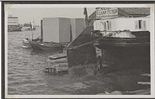
Ombouw en verlenging tot 50 meter voor motortankschip Maurits II van N.V. Gemengde Metaalertsen te Budel in september 1937. Op de achtergrond oliebakken voor een van de oliefabrieken. GAZ Fotonummer: 25_102_06211
