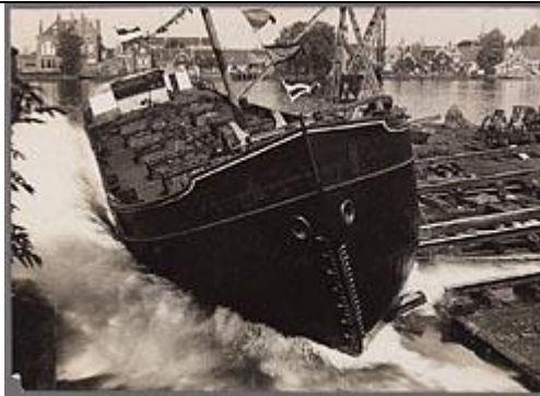
M.T.S. "Olievos", gebouwd door N.V. Zaanlandse Scheepsbouw Mij., Zaandam in 1933 voor N.V. Oliefactorij Pieter Bon Cz. Zaandam. Te water 3 Juni 1933. Afm. 37,50 x 6,25 x 2,20 mtr. Inhoud 275 ton. Motor: 120 Pk Kromhout Diesel. Prijs: F.34000.-. Het schip werd dwars te water gelaten in een smal "haventje" tussen de werf "Czaar Peter" en de pakhuizen "Grote Kaar", "Japan", Kalf, te Zaandam.
