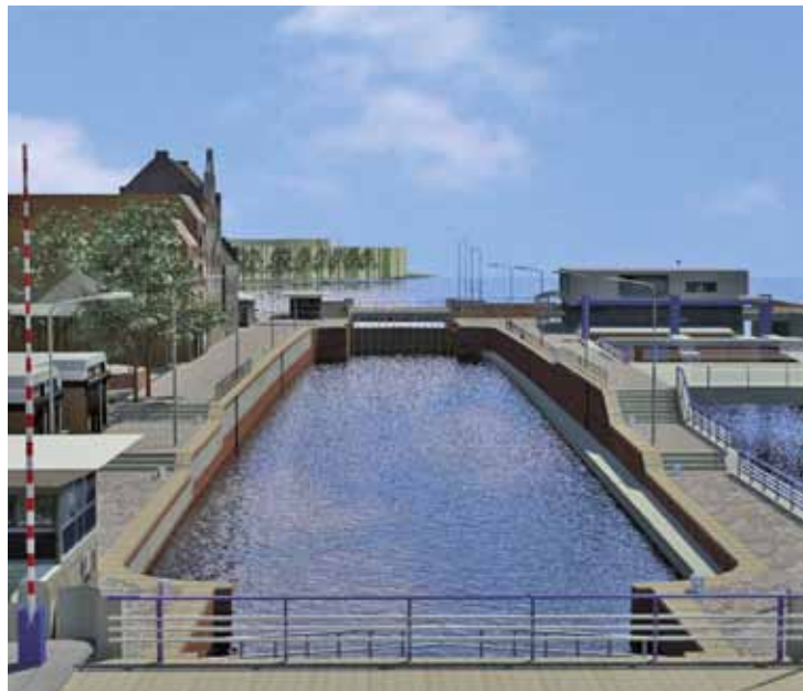
Huidige Wilhelminasluis met komvormige sluisolk
