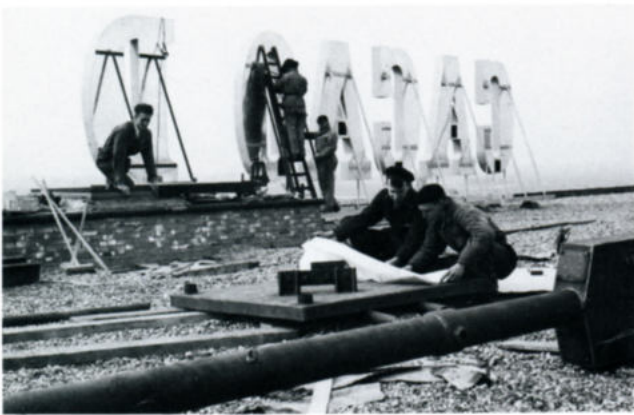
Onze eigen technische dienst plaatst de naam op het dak. Links A. Smit, vooraan N. Beekman.
