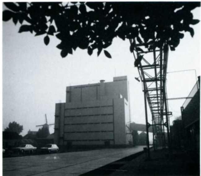
In 1971 wordt gestart met de bouw van de brekerij, die in 1973 gereed is.
