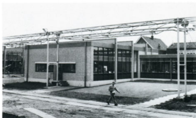
Nieuwbouw oostelijke vleugel laboratorium. De middenvleugel is al in gebruik.
