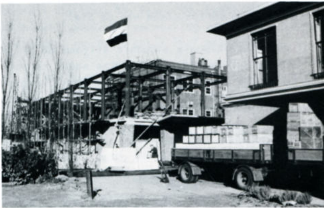
De nieuwe fabriek in aanbouw. Vervoer van boter heeft per schip en ook reeds per auto plaats.
